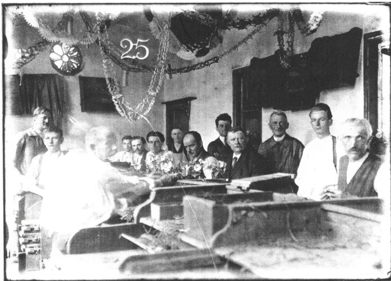
Sigarenfabriek Hutten-Barten 1916, Veerstraat Boxmeer
